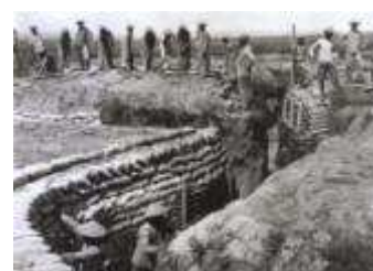
22 Tranchées © Coll. Historial
